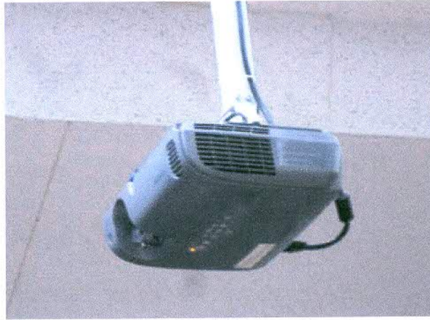
ติดตั้งเครื่องฉายภาพโปรเจคเตอร์กับขายึดติดฝ้าเพดานแบบถาวร
